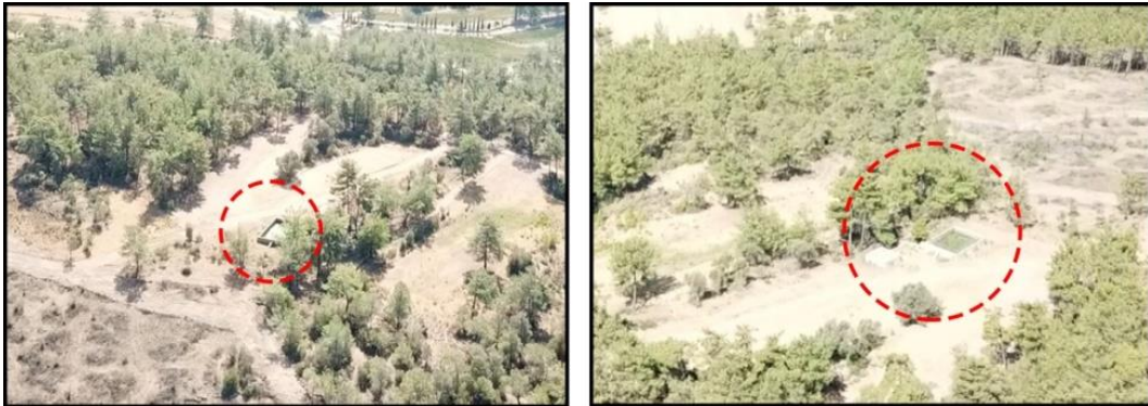
Resim 20: İnceleme Alanı İçerisinde Yer Alan Su Deposu
